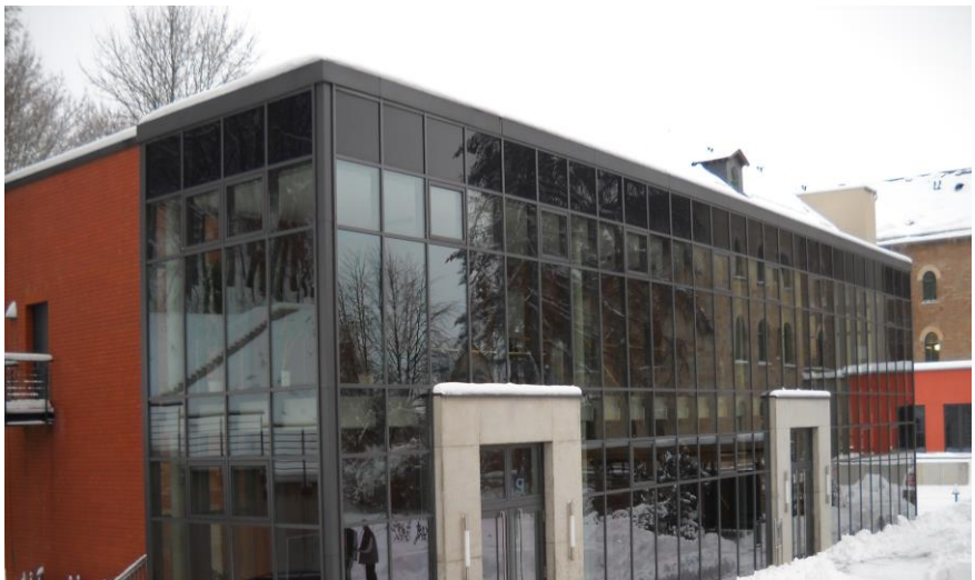
AFI LSA Standort Blankenburg (Lehrsaalgebäude)
